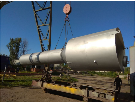
Водонапорная башня ВБР-15
