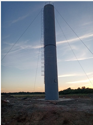
Водонапорная башня ВБР-160
