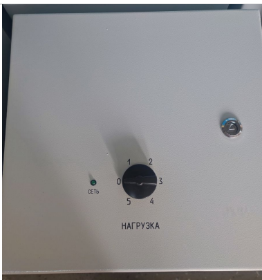
Регулятор скорости вентиляторов 3-х фазный РСВТ7
